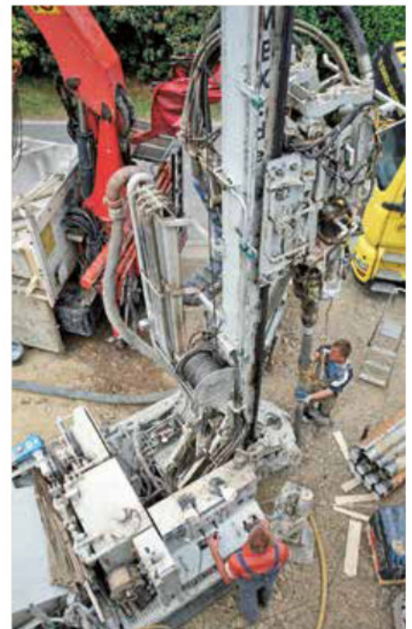
Fossile Brennstoffe Wärmepumpen sorgen für mehr Unabhängigkeit
